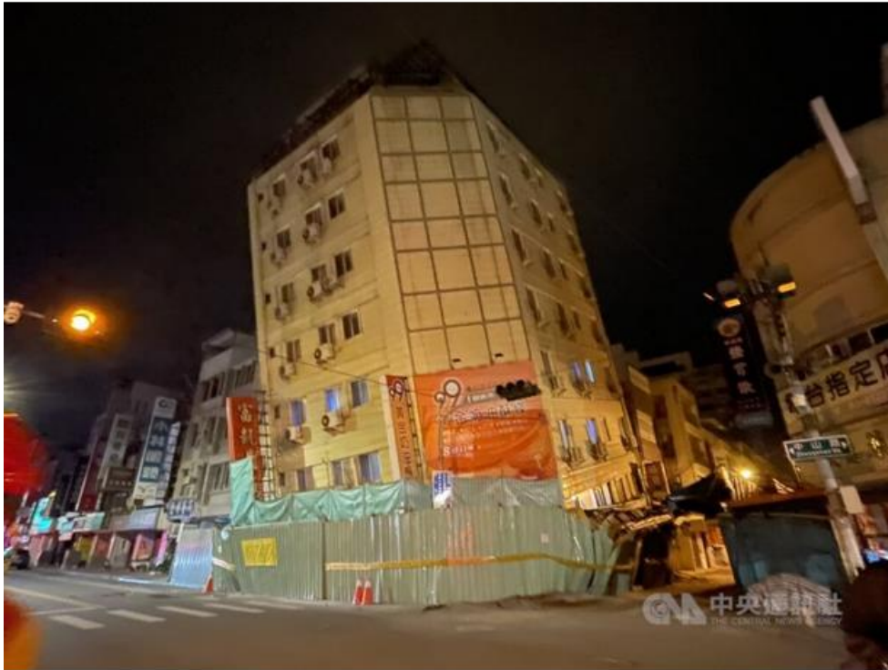
花蓮縣23日凌晨2時32分發生芮氏規模6.3地震，接續又有多次地震，花蓮市中山路富凱大飯店出現傾斜，這家飯店正在整修中，管消已與飯店負責人確認無人受困。中央社記者張祈攝 113年4月23日
