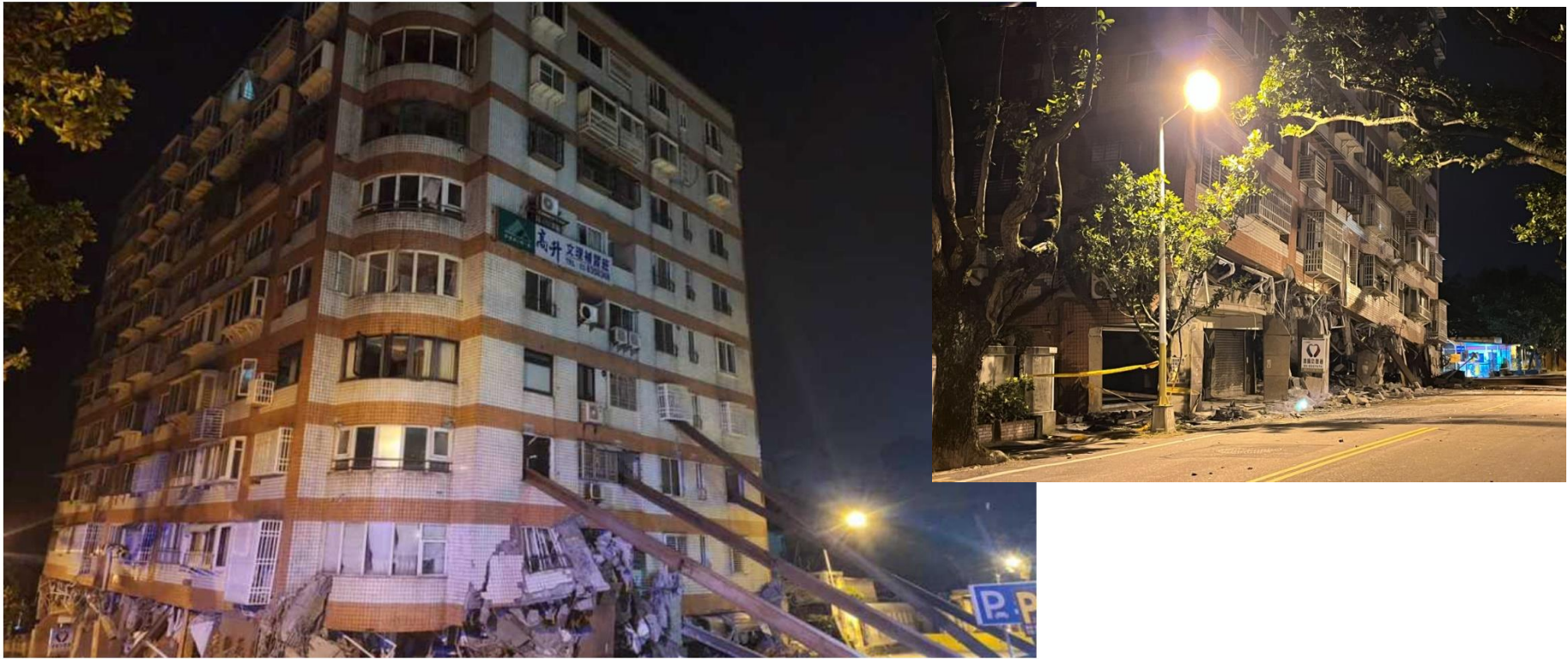
花蓮統帥大樓坍塌「三樓變一樓」，現場支撐鋼樑變形脫落。(花蓮消防局提供)
