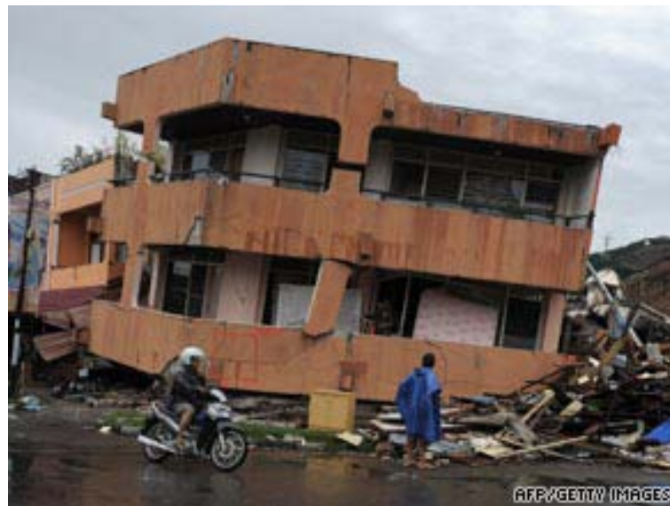
民宅一樓完全倒塌CNN)
